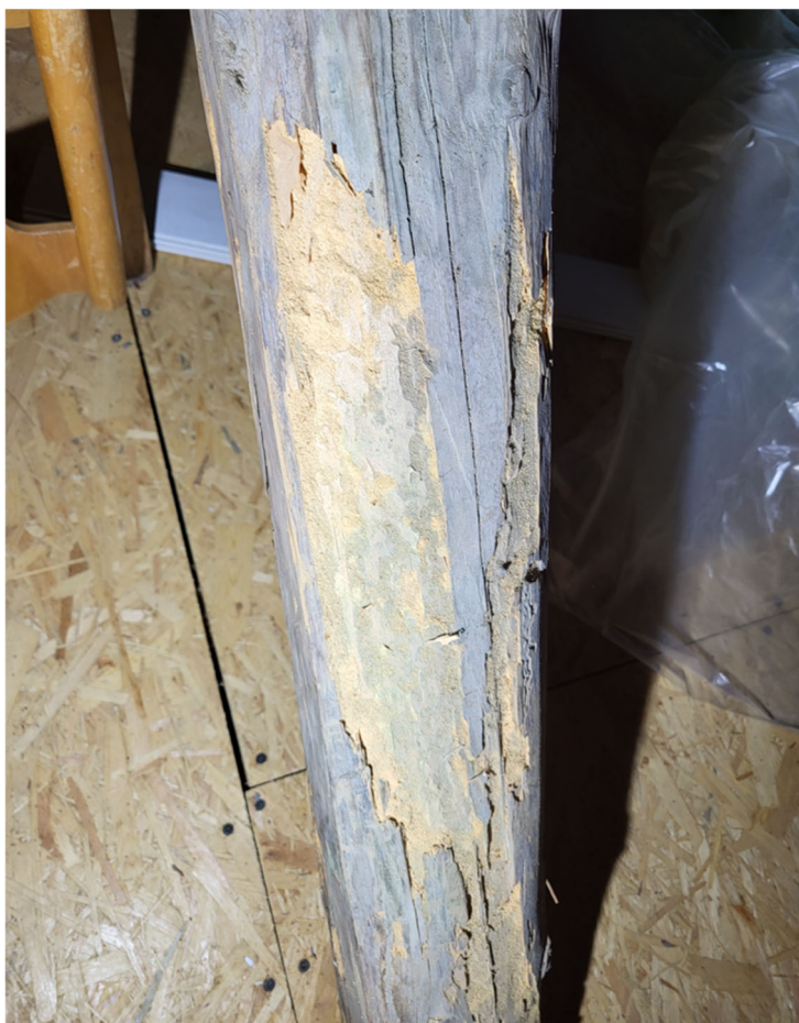
Obrázek 6 Sloupek - poškození dřevokaznou houbou
