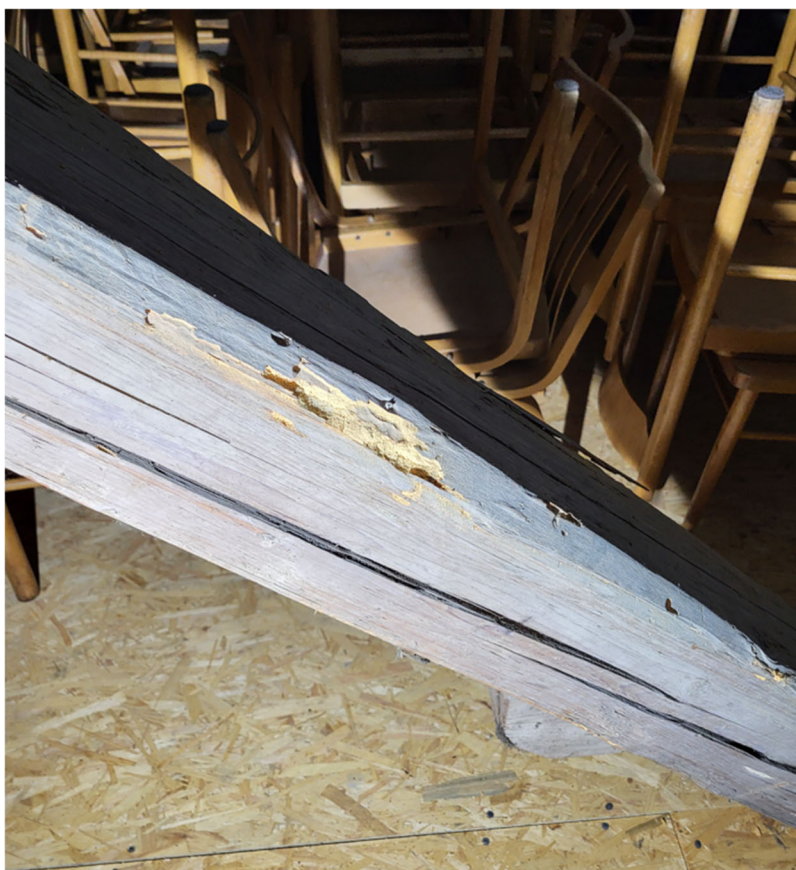
Obrázek 7 Vzpěra - poškození dřevokaznou houbou
